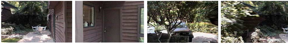
Abbildung 3.22: Die Abbildung zeigt Bildfehler, wie sie bei einem Stitching nach beschriebenem Schema entstehen können. Auf der linken Seite sehen wir an der Hausecke Fehler, die mutmaßlich aus der „fehlerhaften“ Interpolation zwischen korrelierten Punkten stammen. Die rechten Fehler zeigen vermutlich eine zu geringe Auflösung beziehungsweise fehlende Information der Quellbilder, die für das Zielbild interpoliert werden musste. [McMillan und Bishop, 1995]
